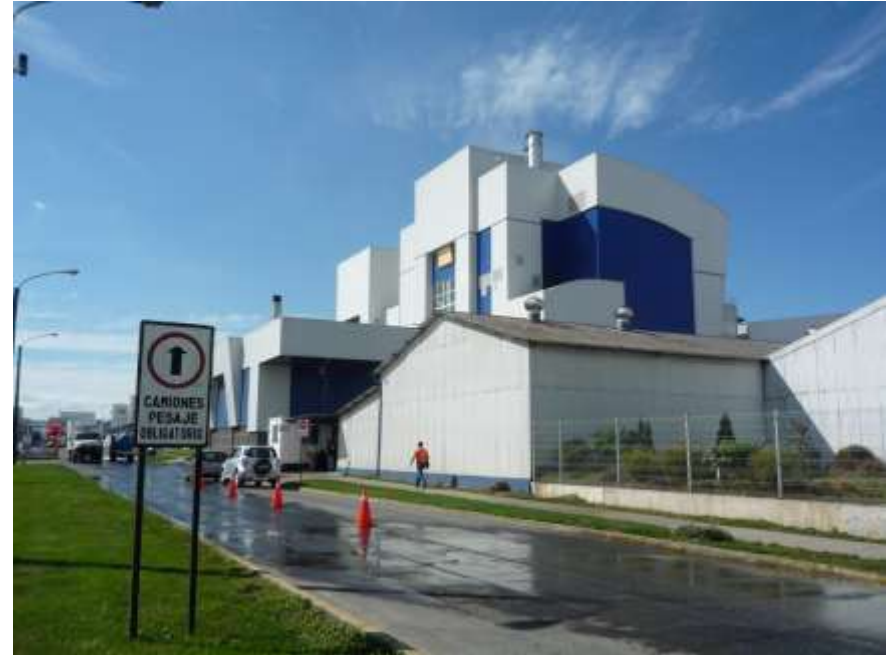
Empresa láctea que trabaja con medición infrarroja en línea
