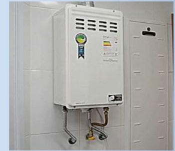
Instalações Prediais de Gás Combustível
